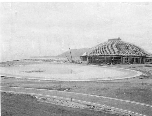
月の海と建設中のスーパーテーマ館（多目的ドーム）
