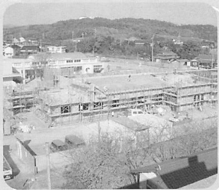
▲保育園前に建設中の健康福祉センター
