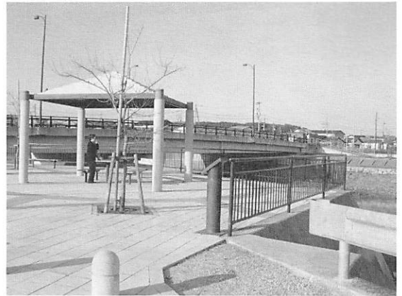
▲阿知須大橋の下に設置された公園にはあずま屋も整備
