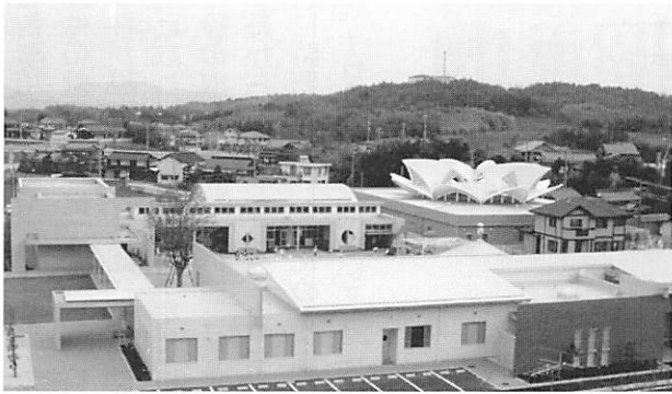
手前は4月オープンした町健康福祉センター「おげんきかん」、その向かいにあじす保育園、右は7月にオープンした町立図書館「きらら館」
