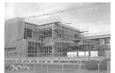
井関小学校の増築工事は来年2月完成予定
