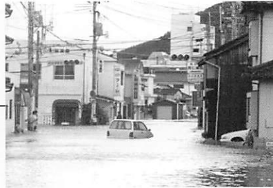
平成11年 台風18号 台風襲来時、大潮の満潮 に重なり浸水被害多数
