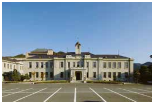
山口県旧県庁舎及び県会議事堂
