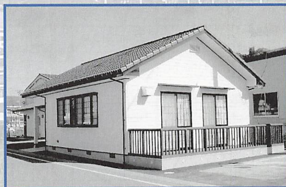
▲ 子育て支援センター建設
