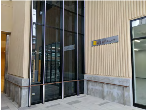
⑤施設棟正面 (R2.3.9 現在)
