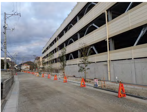
①外観（整備中の外周道路）
