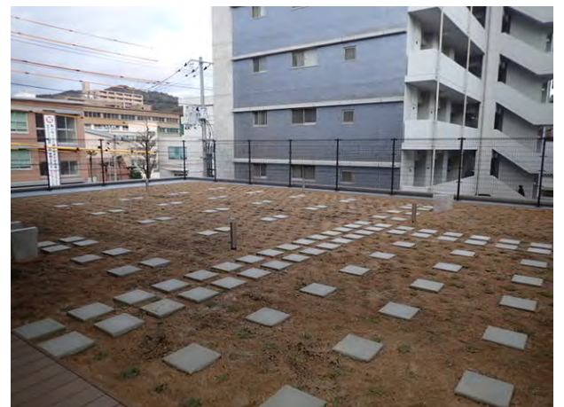
④施設棟屋上広場 (R2.2.末現在)
