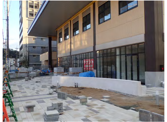
⑥施設棟屋上広場 (R2.2.末現在)
