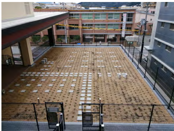
③施設棟屋上広場 (R2.3.9 現在)
