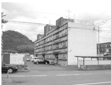
<老朽化した元町第1アパート>
