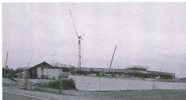
写真●工事が進む「特別養護老人ホーム」
