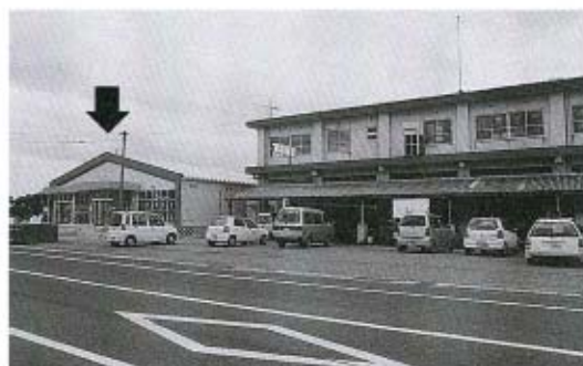
▲「シーマート秋穂」工事中
