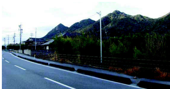
山口南支援学校へ行く途中の新設LED防犯灯
