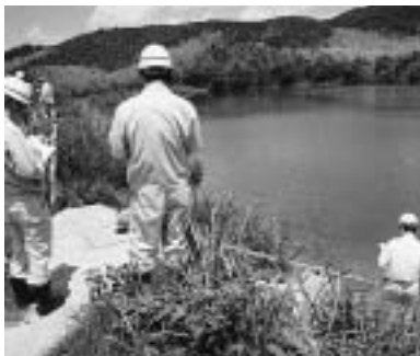
外屋上池の点検風景
