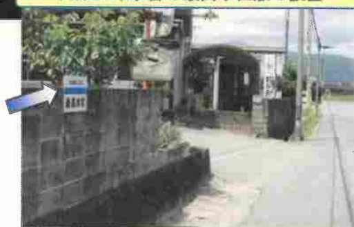
平成21年水害の最高水位版の設置
