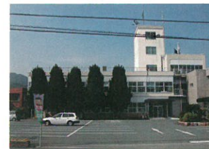
徳地総合支所
