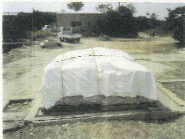
●備蓄用土嚢は、シートをかけて備蓄します
