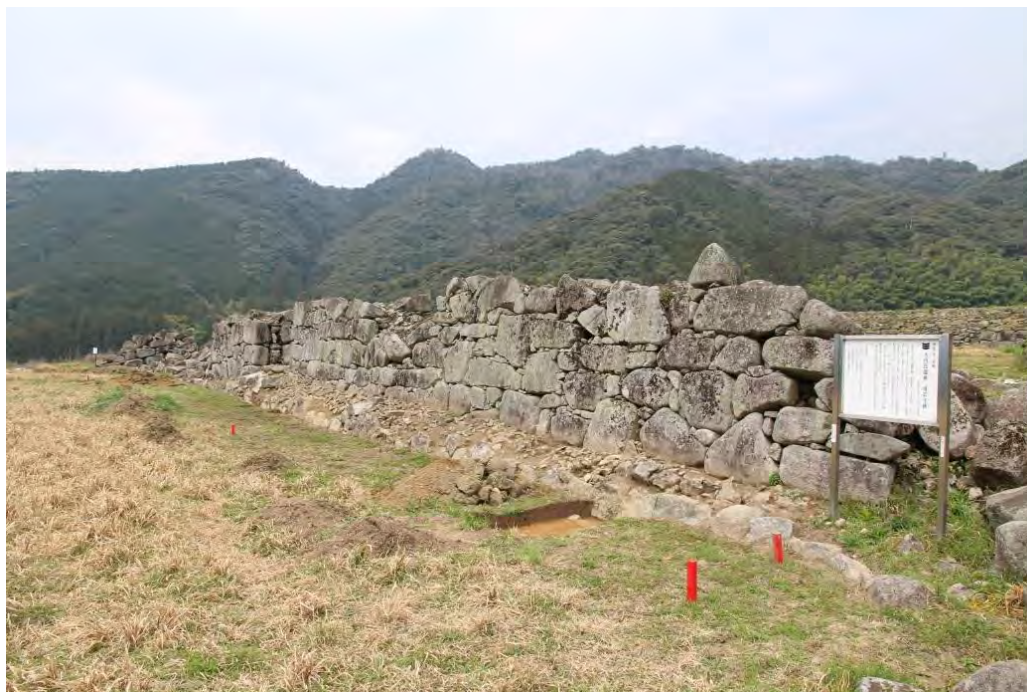
写真3-3 凌雲寺跡の伝総門跡(石垣101)
