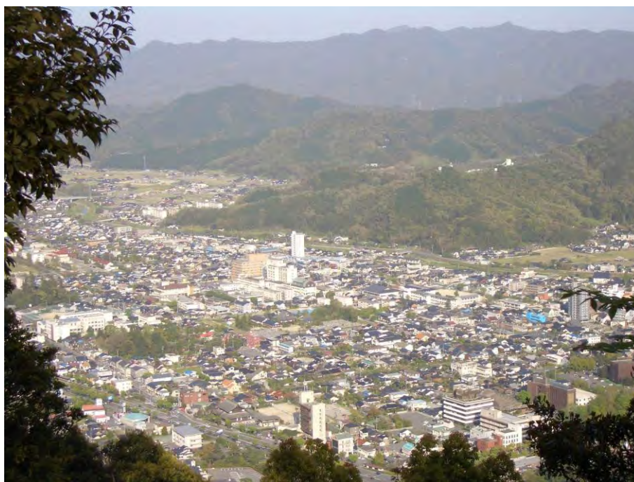
写真 3-2 高嶺城跡からみた館跡・築山跡
