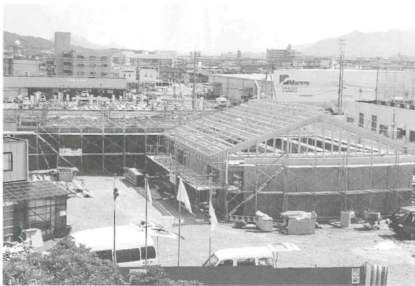
▲建設工事中の写真（9月撮影）
