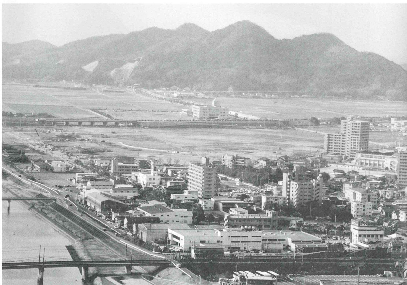
▲県の玄関口にふさわしい基盤整備となる小郡駅前第3土地区画整理事業(石ヶ坪山からのぞむ)
