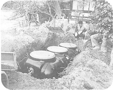
浄化槽設置工事
