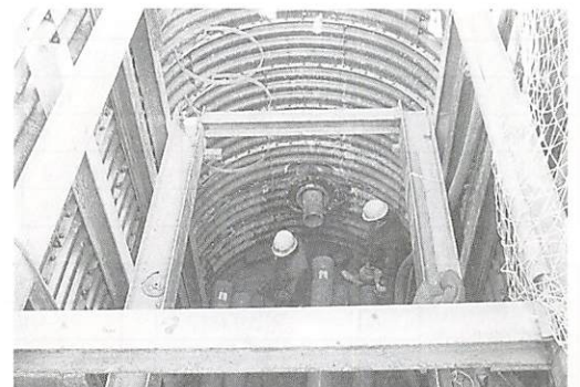
公共下水道本管建設工事(平川)
