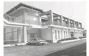
今年3月に完成した大内小屋内運動場
