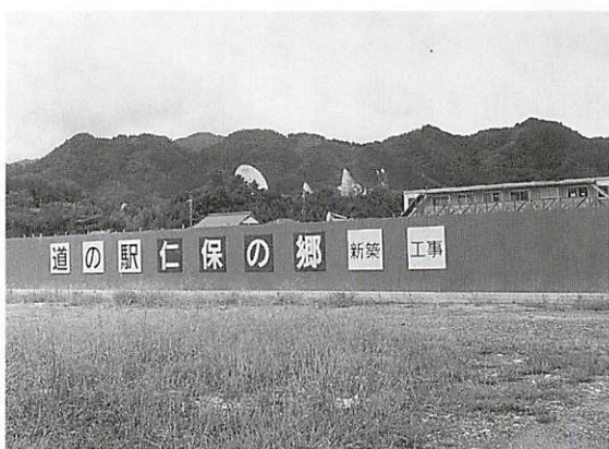
建設中の道の駅「仁保の郷」
