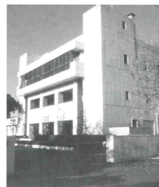
▲町浄化センター
