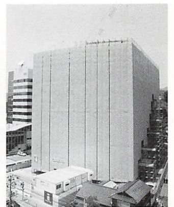
開発地区Ⅱに建設中のNTTドコモ中国山口ビル
