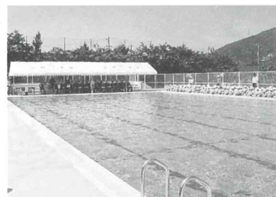
▲県内では初めて浄水装置を備え、災害時には2,000人分の飲料水を4日間供給できる。
