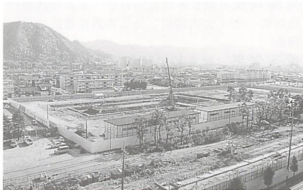
▲2003年秋開館に向け、山口情報芸術センターの工事が中園町で始まりしました。(8月8日) ※写真は11月16日現在の工事の様子
