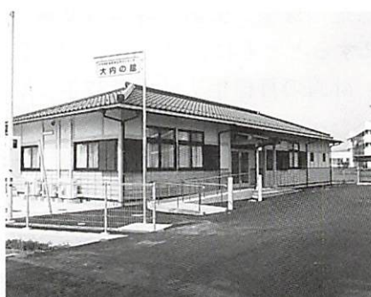
大内矢田に竣工した大内地区高齢者生きがいセンター「大内の館」
