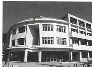
完成した白石小学校校舎（白石一丁目）
