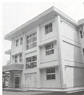
工事の完成した大歳小学校の増築校舎
