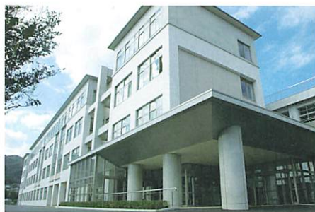
小郡中学校新校舎
