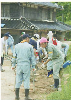
災害復旧作業の様子
