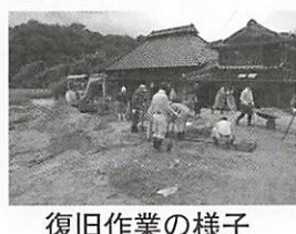
復旧作業の様子
