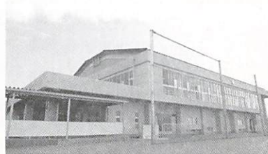
井関小学校屋内運動場
