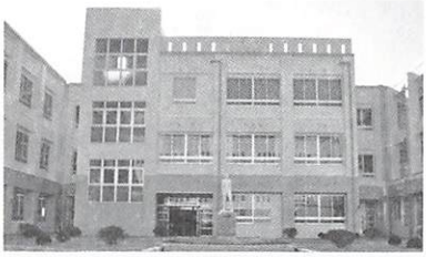
白石中学校増改築校舎
