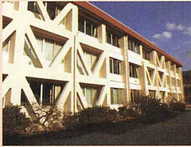
補強工事が完成した阿東東中学校 (平成21年度事業)
