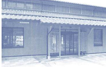
環境にも配慮し、屋根には太陽光発電パネルを設置
