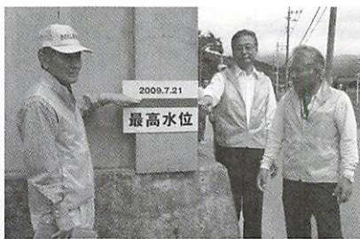
平成 21 年の豪雨災害での浸水状況を示す「最高水位板」
