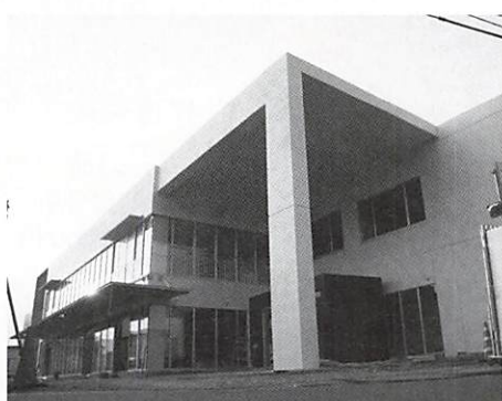
5月のオープンに向けて工事が最終段階の嘉川地域交流センター
