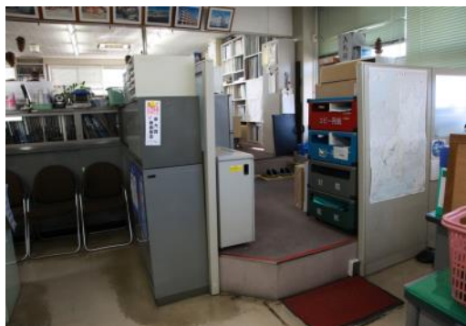
執務室内の段差
