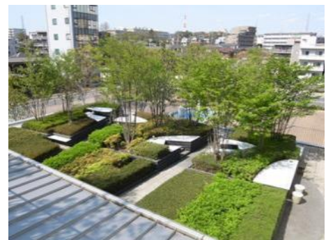
屋上緑化の例（町田市）
