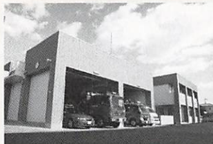
南消防署阿知須出張所の新設
