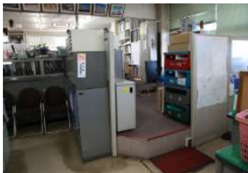
執務室内の段差
