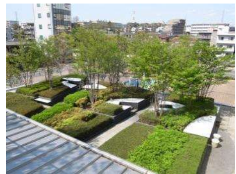
屋上緑化の例（町田市）
