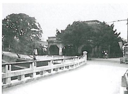
亀山橋から見た旧教育会館 (1983年)
