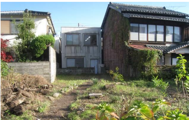
③商店街背後の老朽住宅と空き地
