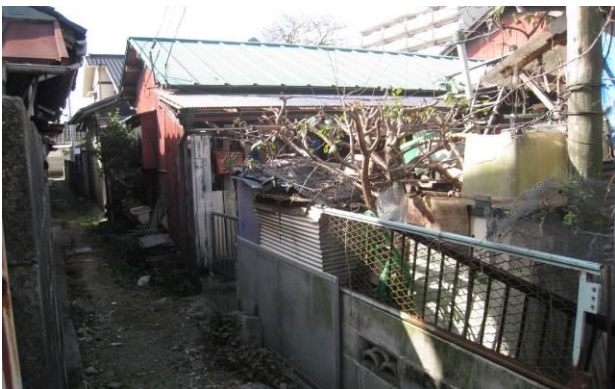
⑤無接道の老朽住宅
