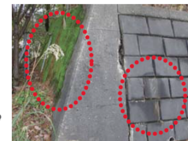
水がしみだしている擁壁 湧水部分にコケが生えている擁壁 (提供：社団法人 全国宅地擁壁技術協会)
