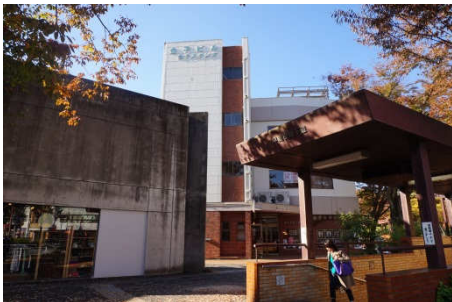
市民会館東側付近
