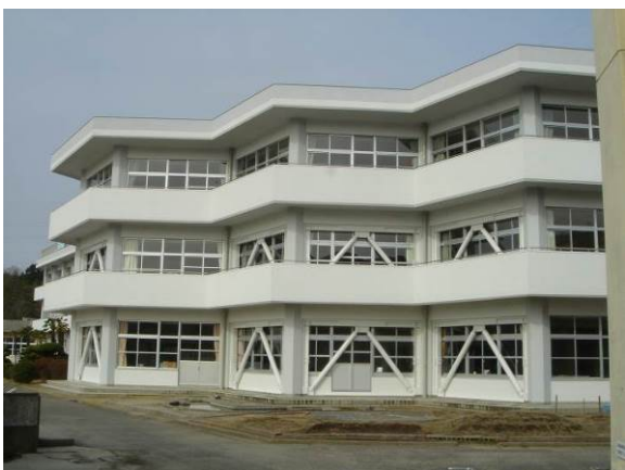
耐震補強後の上郷小学校（平成 24 年度に完成）
