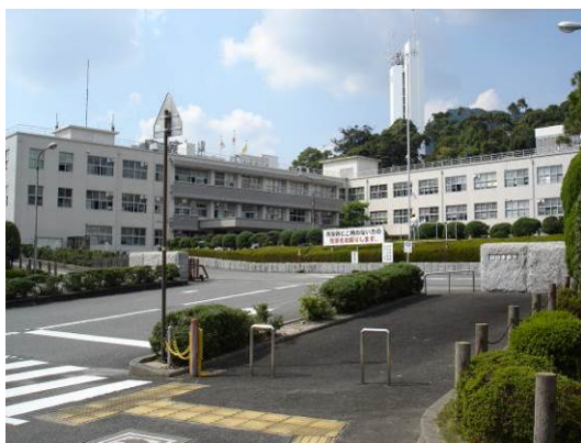
山口総合支所
