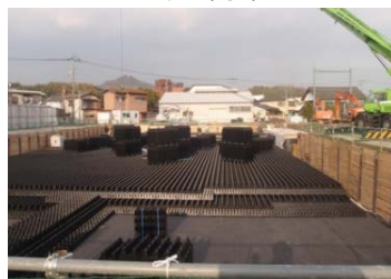
総合浸水対策事業 (雨水貯留施設の整備イメージ)
