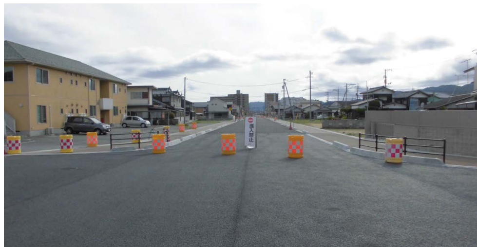
住民の利便性、近隣一帯の渋滞緩和に向けた道路整備(市道東山通り下矢原線)
