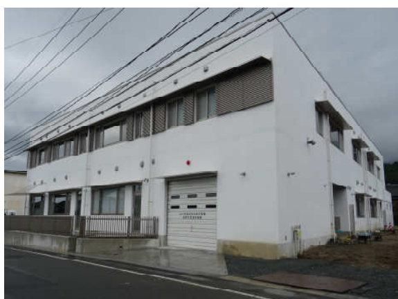
消防車庫側から見た建物全景
