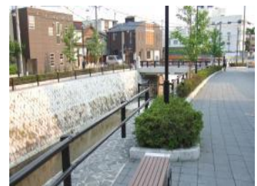
一の坂川周辺整備
