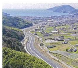
一般国道2号富海(とのみ)拡幅4車線開通(令和8年3月5日)
