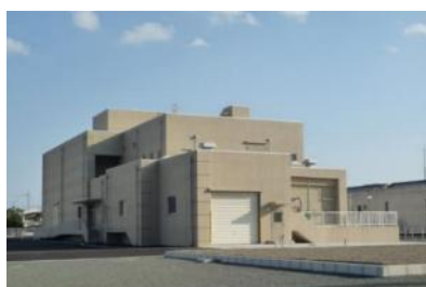
【長谷ポンプ場の整備】
